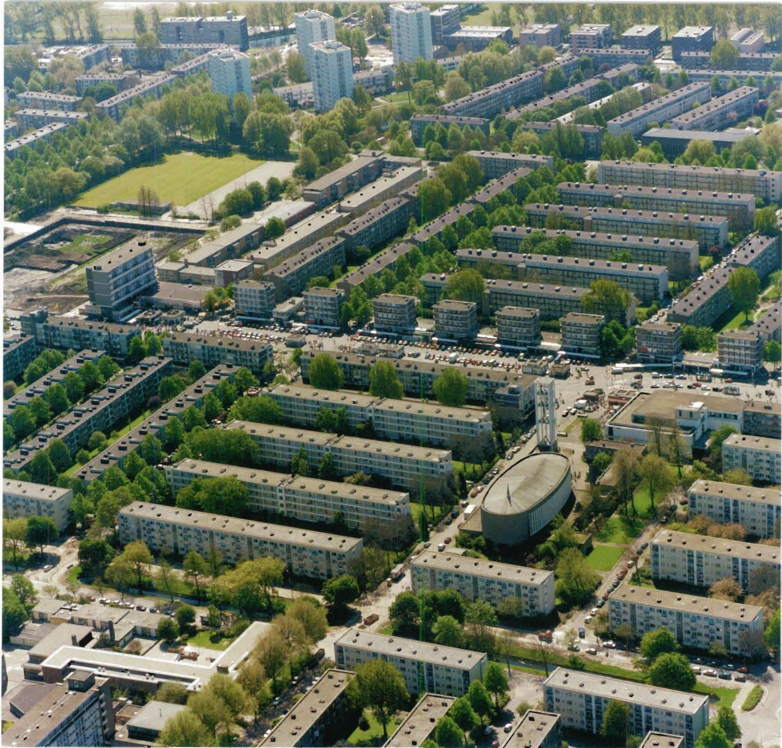
Luchtopname Morgenstond-midden. De bouwblokken volgen de richting van het rechte stratenpatroon.
