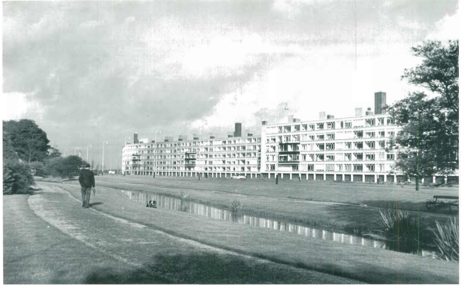
De langgerekte flatbebouwing langs de Bezuidenhoutseweg met de groenstrook van de "parkway". Opname circa 1965.
