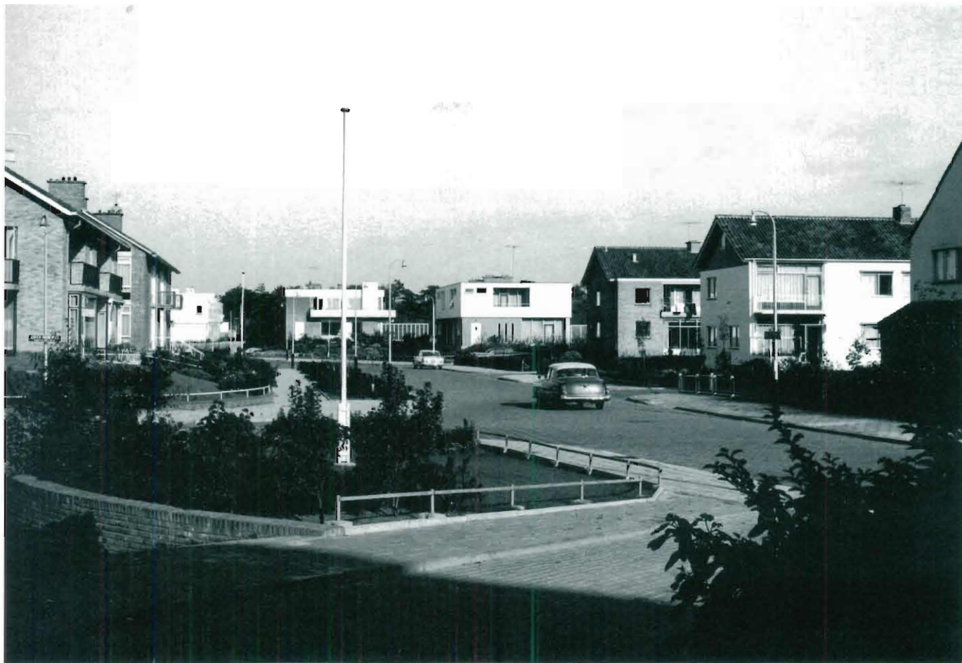
Groen is in de wijk vrijwel alleen aanwezig in de vorm van private tuinen zoals onder meer te zien is langs de Maurits de Brauwweg. Opname uit oktober 1962.
