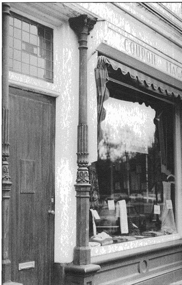
88. Winkelpui aan de Toussaintkade met gietijzeren zuiltjes van de Pletterij.
