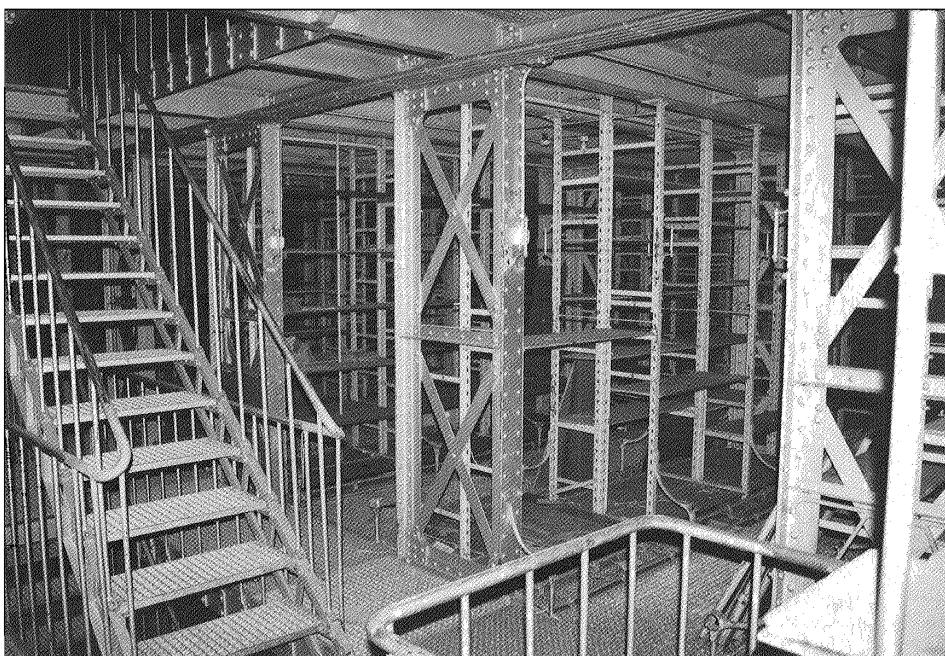
69. Boekenschappen en ijzeren constructies in het voormalig depot van het Rijksarchief aan het Bleijenburg.
