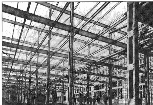
89. De stalen constructie van de Rademakerfabriek aan de voormalige Slachthuis-kade (nu Neherkade), die in 1922 geleverd werd door de Pletterij.
