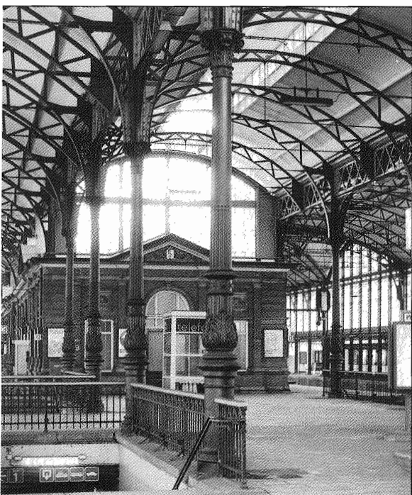
86. De perronoverkapping van station Hollands Spoor voor de brand van 1989. Duidelijk zichtbaar zijn de sierlijke giet-ijzeren zuilen.
